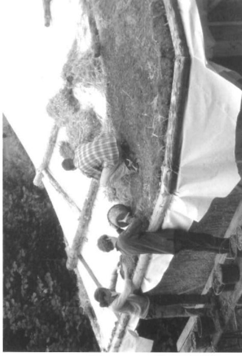
10.6 Montaje de sustrato
