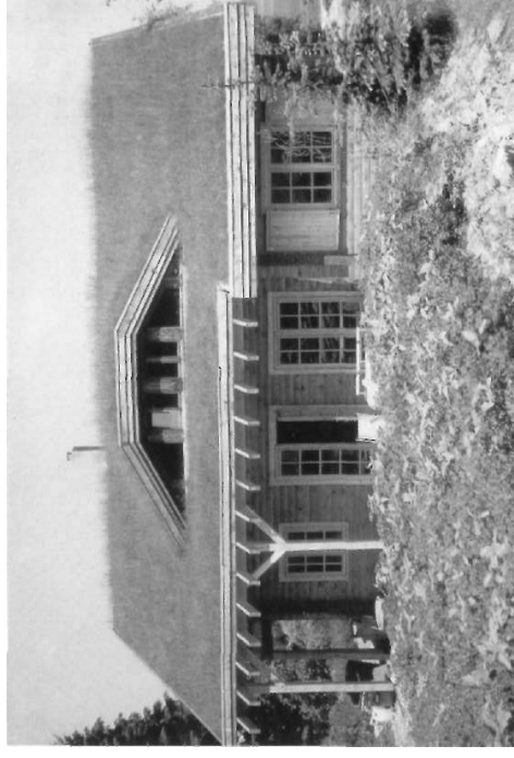
12.1. Techo de césped con lucarna integrada
