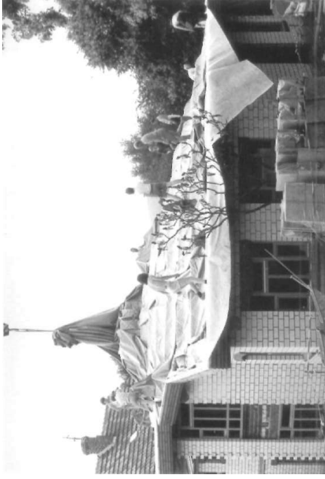
10.1 Montaje con guía de una membrana de techo prefabricada
