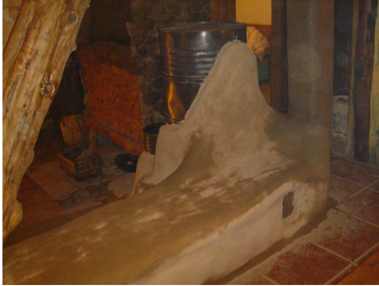
La misma vista de la estufa recién pintada y en funcionamiento.
